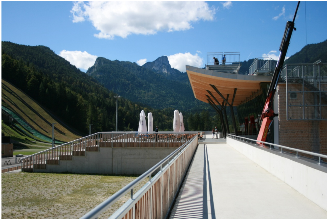
Abbildung 16: Blick auf die permanente Haupttribüne vor der Chiemgau Arena. Auf den beidseitig angelegten Schotterrassen wird die Haupttribüne temporär für Veranstaltungen errichtet. Auf dem Dach des Gebäudes wird gerade die Installation der Mediencontainer vorbereitet.
