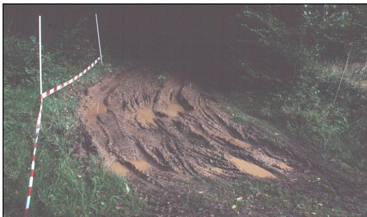
Abbildung 7: Starke Vernässung führt zu Spurrillen und Wegverbreiterung
