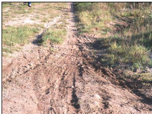
Abbildung 10: Sich flächig ausdehnende Erosion an einer Überholpassage
